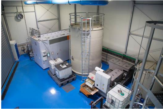
Bild Nr. 09-01 MK_RU-VAnlage.jpg. MKR Metzger hat für RUAG das beste Gesamtpaket einer Verdampferanlage geliefert.
