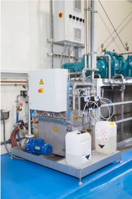
Bild Nr. 09-09 MK_RU-Dosierer.jpg. Dosierstation für die Reinigungsmedien.
