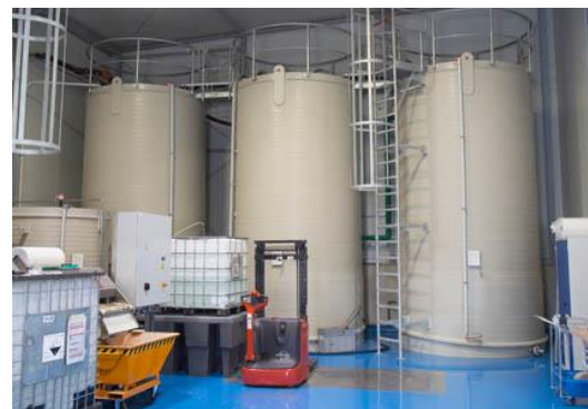
Bild Nr. 09-04 MK_RU-VorlageTanks.jpg. Gesammelt wird das zugeführte Prozesswasser zunächst in drei 24 m 3 fassenden Rundbehältern.
