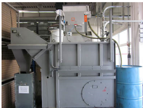
Bild Nr. 03-03 MK_Vorlagetank-TB250.jpg Mittels eines Kratzertanks und eines integrierten Fremddölabscheiders TB 250 von MKR-Metzger werden Schlamm und Fremddöle wirkungsvoll abgeschieden.
